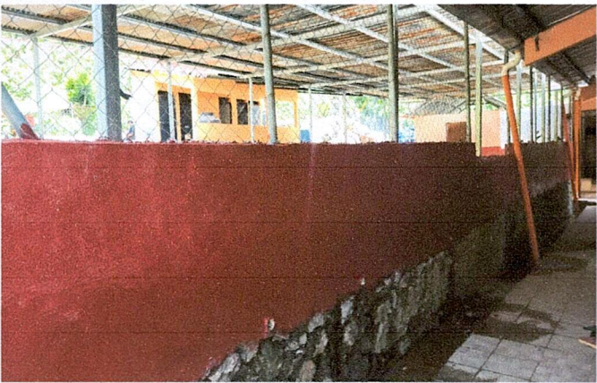
Foto 3: Modulo Muro Perimetral
